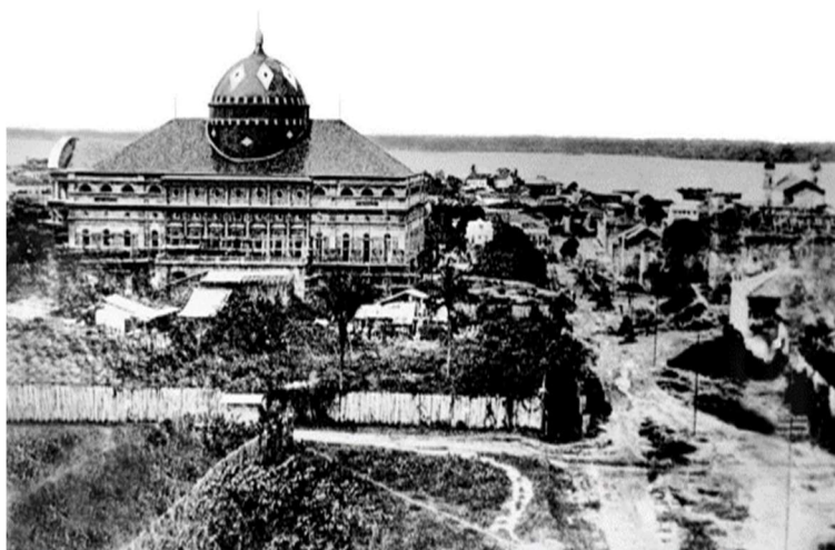
Foto do Teatro Amazonas em construção (1896).
